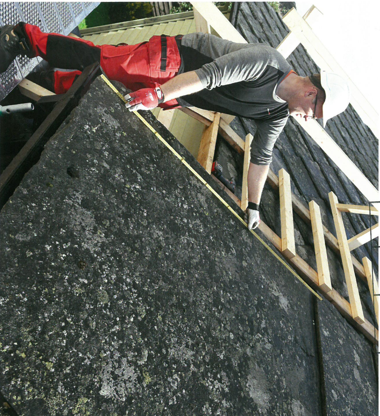
Takvøle Agatunet 2015. Handverkar Morren Haavik måler storleik på takhelle. Takhella vog over 400 kilo.
